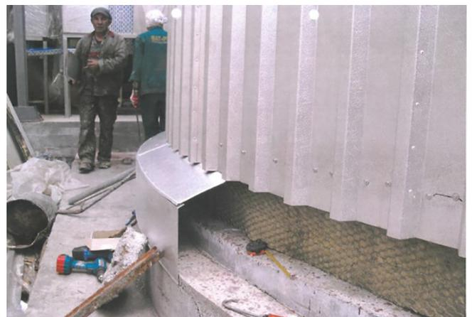
Abbildung 8: Bauseitig ist der Bereich zwischen Tankfuß und Isolationsbeginn zu beachten
