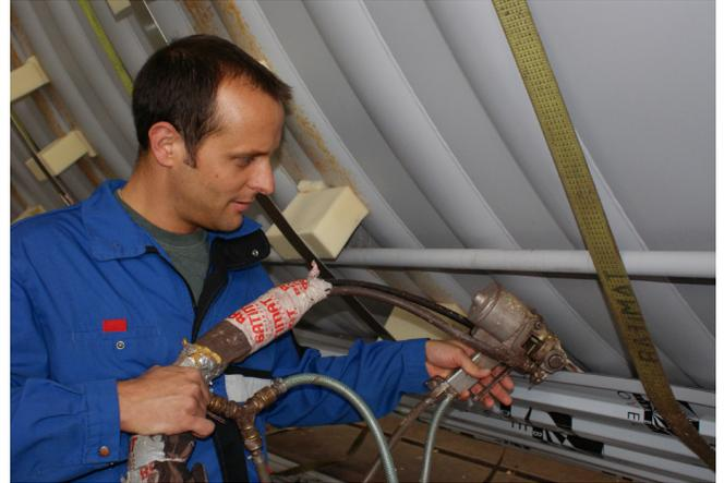
Abbildung 6: Ein ZKT wird isoliert
