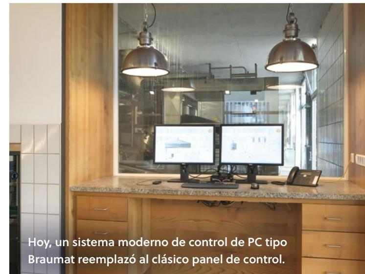
Hoy, un sistema moderno de control de PC tipo Braumat reemplazó al clásico panel de control.
