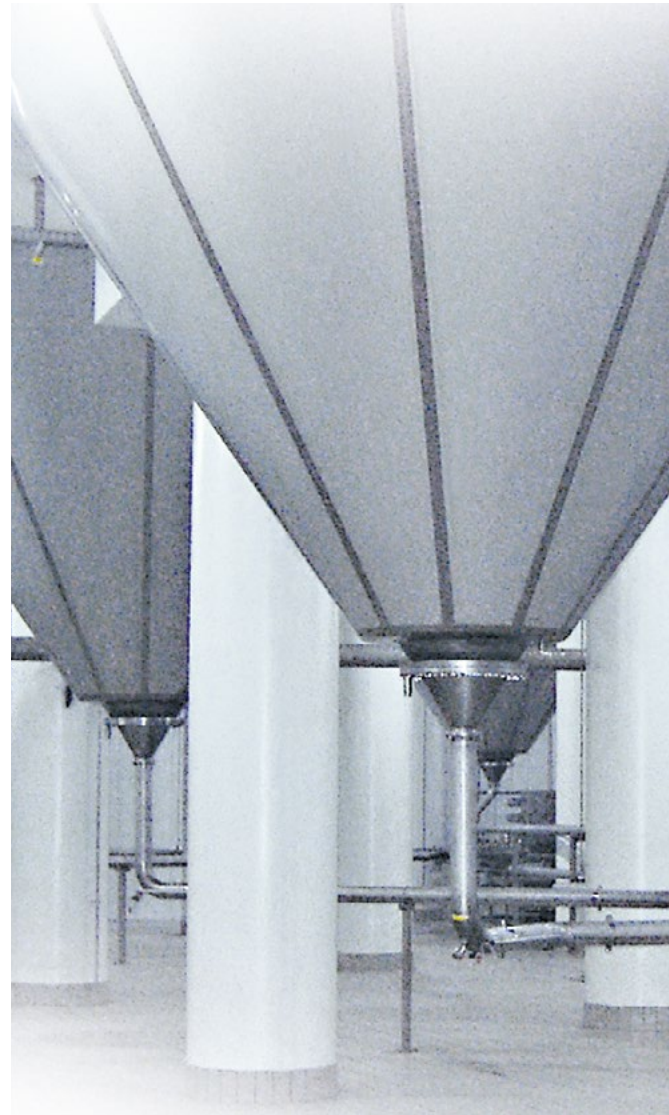
Decke mit Gebäudestützen aus Stahlbeton; 4 Auflagen je Tank, besonders für sehr große Tanks geeignet
